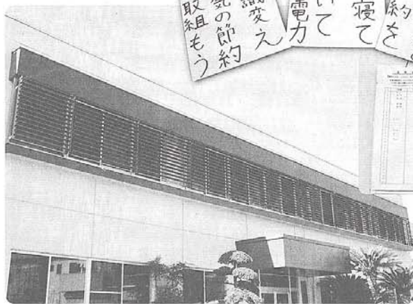
社屋に設けた屋外遮熱ルーバーは放射熱を中に入れない
